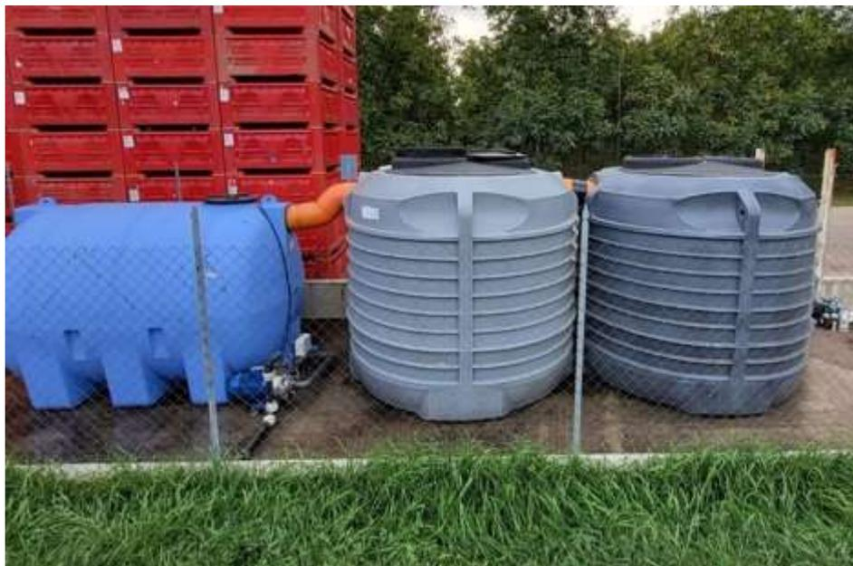
*Da destra a sinistra: dissabbiatore, degrassatore e accumulo con pompa esterna di pressurizzazione del fitro autopulente*
